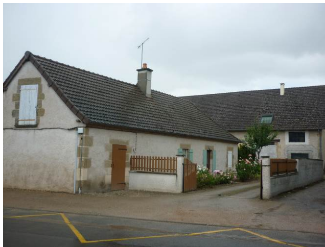
Maison typique du centre bourg
