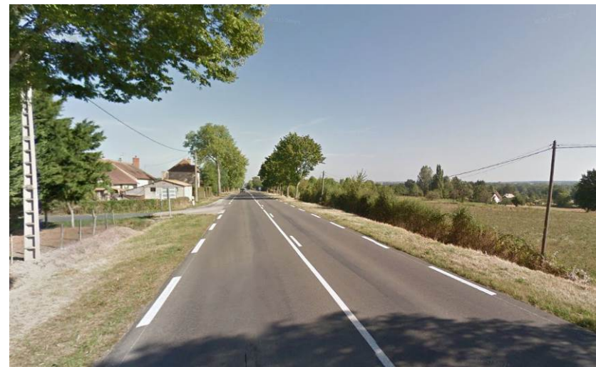
Bâti historique aligné parallèle à la voie, chemin d'accès aux hameaux en retrait et proche de l'Allier
