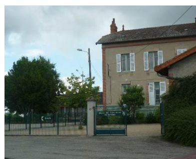
Bibliothèque et salle des associations, avec les équipements sportifs à l'arrière
