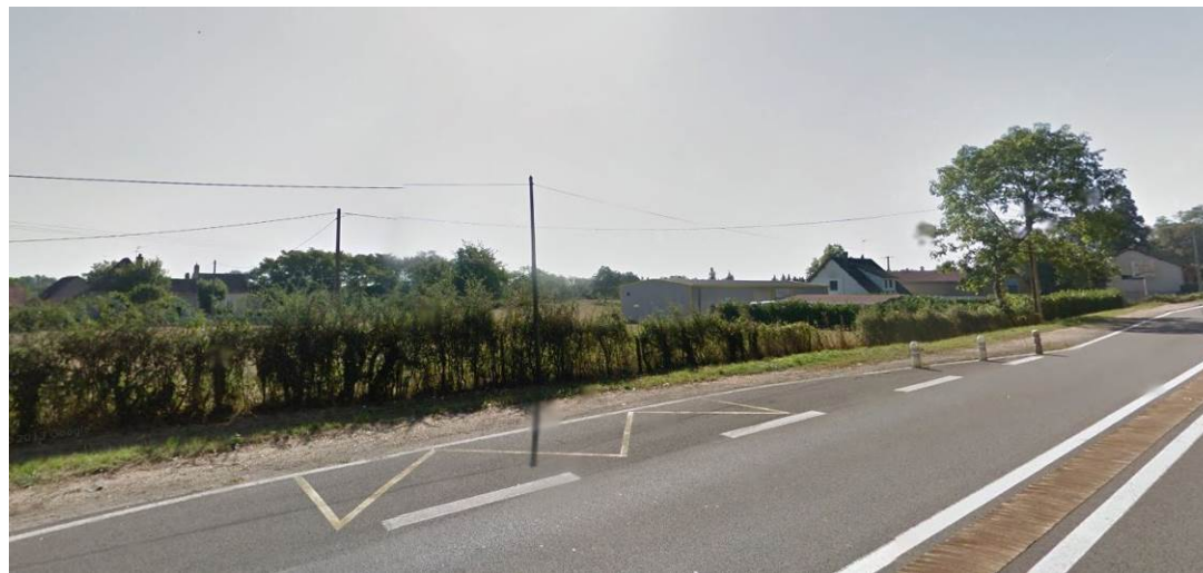
Tissu ancien et locaux d'activités, visibles depuis la route
