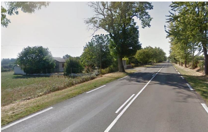
Pavillon récent construit en bord de route, entrée individuelle sur la RD 2009
